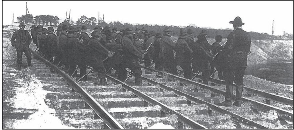
Gleisrücken mit Muskelkraft und Ruckeisen im Tagebau um 1900
