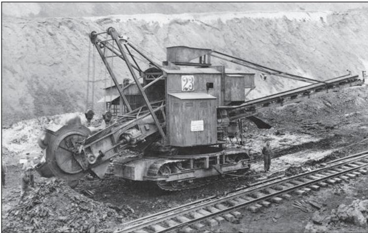
Einer der ersten Schaufelradbagger, der elektrisch betrieben wurde. Der Schaufelinhalt betrug 100 Liter. Der elektrische Strom kam über ein 3-kV-Kabel
