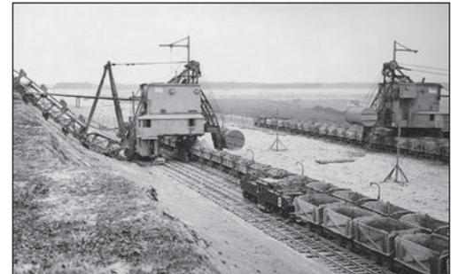
Flachbodenselbstentlader im Einsatz mit Elektrolok
